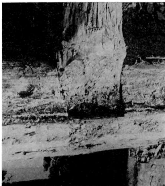
Рис. 22. «Глухая врубка» переводины (сруб 7М)
