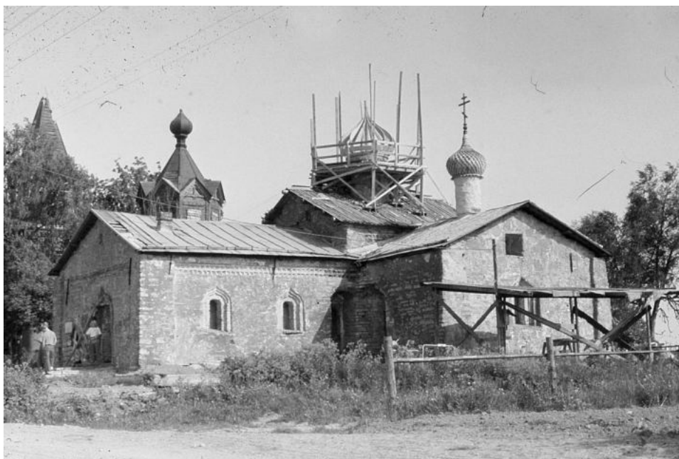
Рис. 4. Реставрация храма свт. Василия Кесарийского. Начало работ. Фото 1991 г
