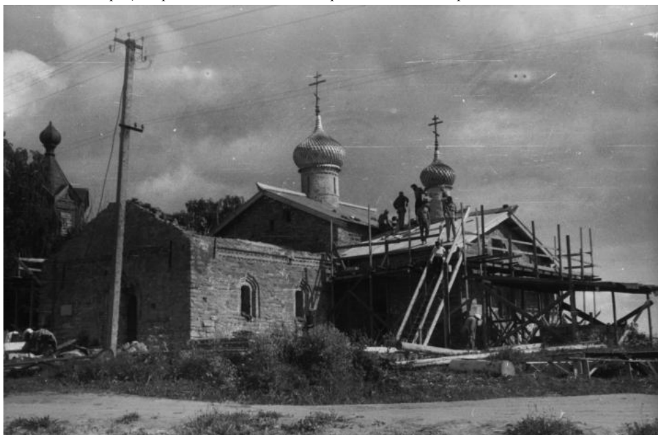
Рис. 5. Реставрация храма свт. Василия Кесарийского. Восстановление кровли на приделе Благовещения. Фото 1992 г.
